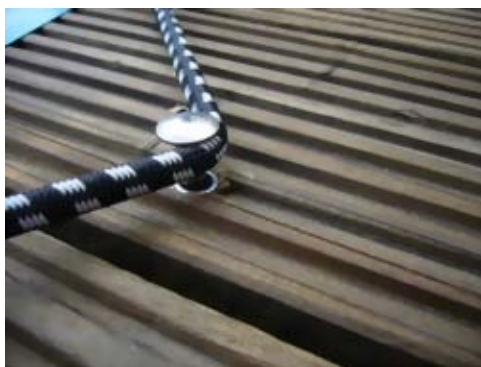
Einfache Lösung: Schlossschraube versenkt sich ohne Gummi von selbst
