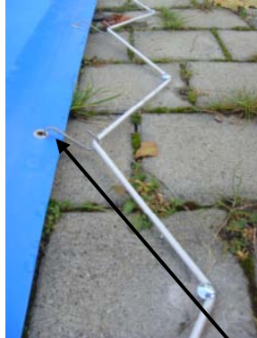
Eingebauter Pool mit Haken befestigt. Sicherlich die beste Möglichkeit, da die Plane ohne Seil in den Nieten schnell aufgerollt werden kann
